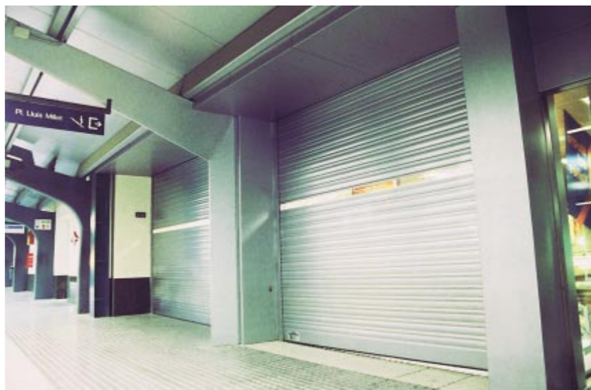
Aluvision con 1 línea de visión en policarbonato
