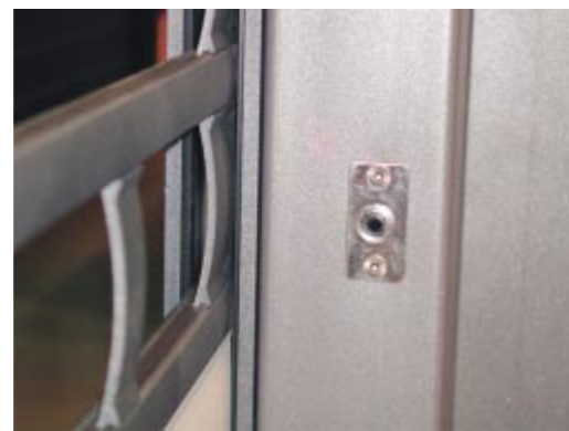
Detalle perfiles, guía y célula antisabotaje
